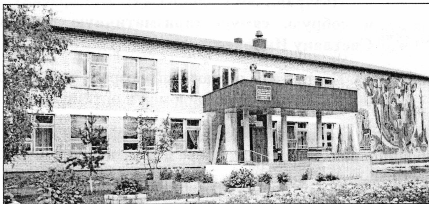
Начальный корпус Ульканской средней школы № 2 в ожидании летнего ремонта
